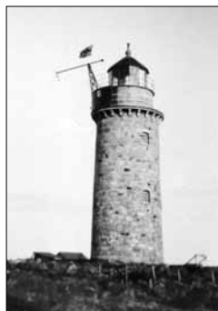
Fyrtornet med knallsignalsapparät.
