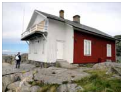
Islandsbergs fyrplats. Fyren var placerad i balkongrummet.
